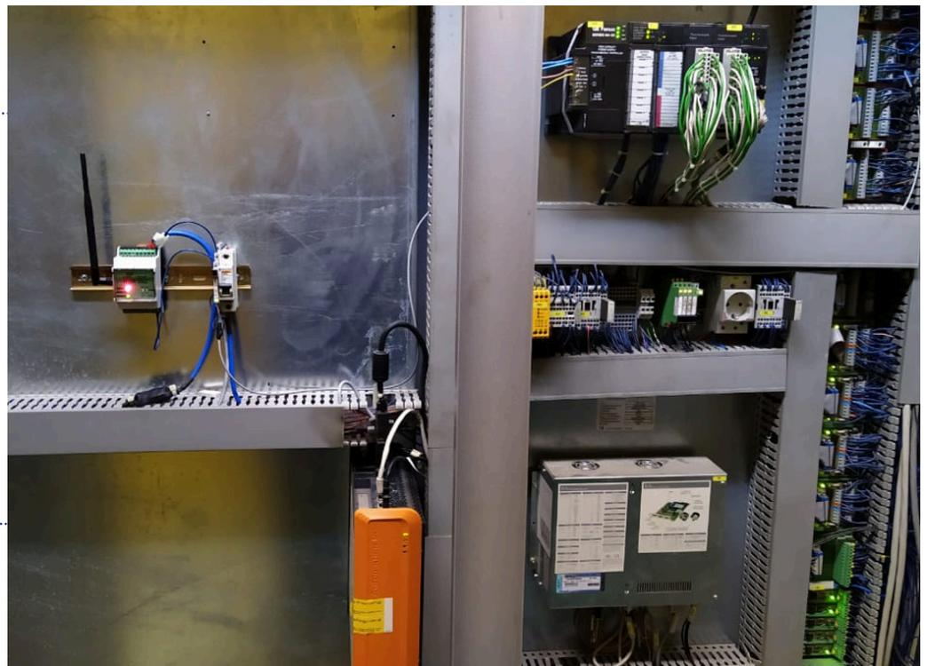
Figura 3. Sistema de monitoreo de estado de funcionamiento y productividad de una máquina industrial. Equipo de telemetría a la izquierda de la foto. Fuente: Los autores.
