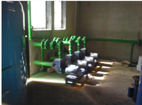
Ilustración 1. Sistema de bombeo múltiple. Elaboración propia.
