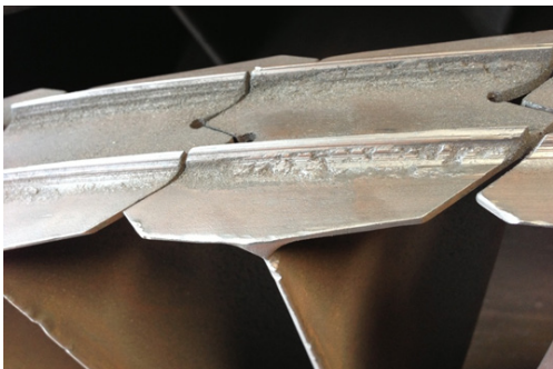
Evidencia de Rozamiento Radial en álabes de 3ra etapa Fuente: Propia
