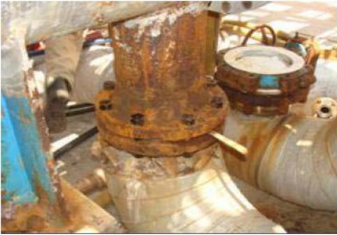
**Fotografías 4, 5, 6 y 7.** Corrosión atmosférica en componentes del intercambiador de calor. Fuente: El autor.
