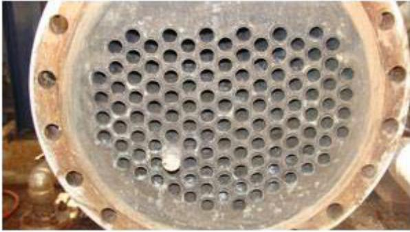
**Fotografía 8.** Vista frontal del haz tubular donde se identifica colocación de un tapón por falla en uno de los tubos. Fuente: El autor.
