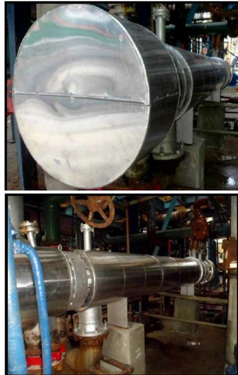
**Fotografías 13 y 14.** Intercambiador de calor HE-E101-A instalado en su área de trabajo y aislado térmicamente. Fuente: El autor.
