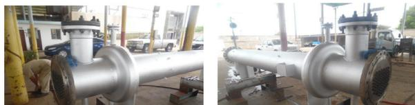
**Fotografías 9 y 10.** Reemplazo total de los componentes externos del intercambiador de calor HE-E101-A conservando el mismo haz tubular. Fuente: El autor.
