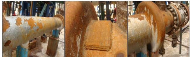
**Fotografías 1, 2 y 3.** Corrosión bajo aislamiento (CUI) en la superficie externa del intercambiador de calor. Fuente: El autor.
