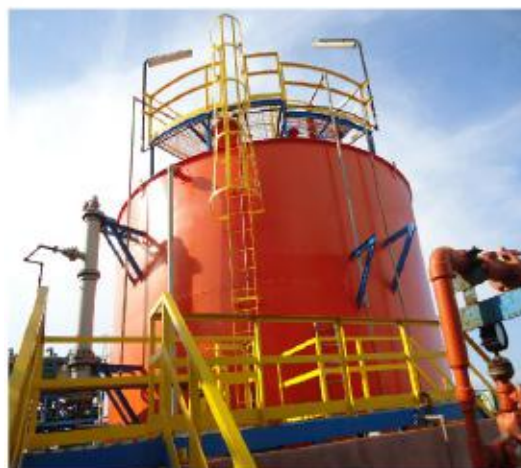
Fotografía 7. Tanque para el almacenamiento de HCL finalmente construido.
