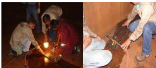
Fotografía 6. Prueba de Vacío en las juntas del piso del tanque.
