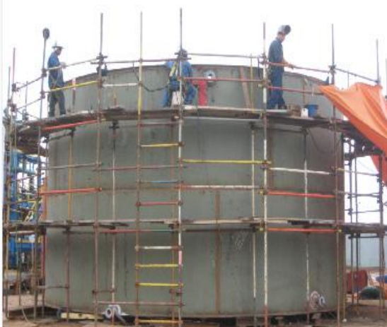
Fotografía 1. Construcción de la pared del tanque.
