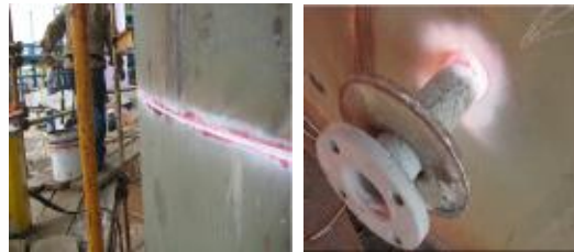
Fotografía 3. Prueba de Líquido Penetrante en soldadura circunferencial y cuello respectivamente.
