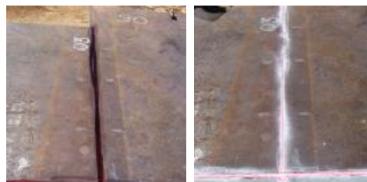
Fotografía 4. Prueba de Líquido Penetrante en juntas del piso del tanque.
