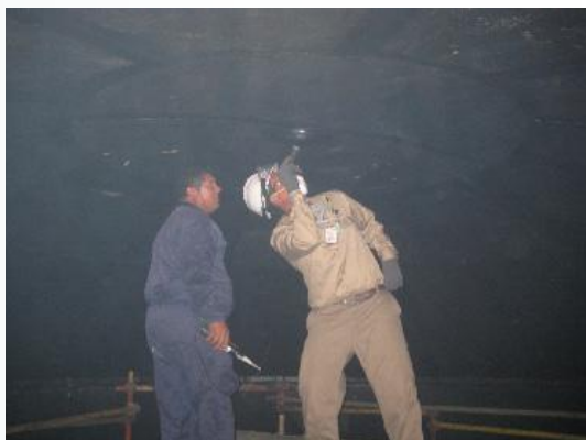
Fotografía 7. Inspección al recubrimiento interno mediante Prueba de Spark Test antes del curado.
