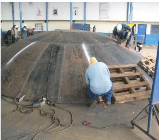
Fotografía 2. Construcción del techo del tanque.
