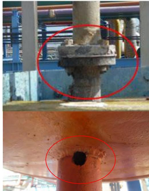
Figura 7. Fallas encontradas en boquillas de entrada y drenaje del recipiente
