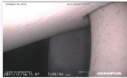
Fig.11. Alabe Estator 2da Etapa Turbina de Baja (Fuente: EYM Solutions, Maturín)
