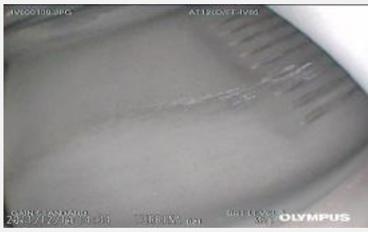
Fig.8. Orificios de Enfriamiento Álabes Estator 1era Etapa (Fuente: EYM Solutions, Maturín)
