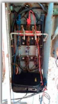
Figura I Conexión del analizador de redes
