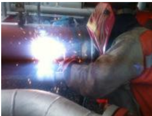
Img. 02.- Reparación permanente con soldadura, sistema de tuberías PC Jusepín 12 PDVSA CGO
