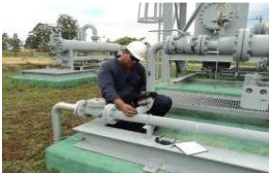
Img. 03.- Seguimiento de inspección IMEE, sistema de tuberías PC Uracoa BS PDVSA CGO
