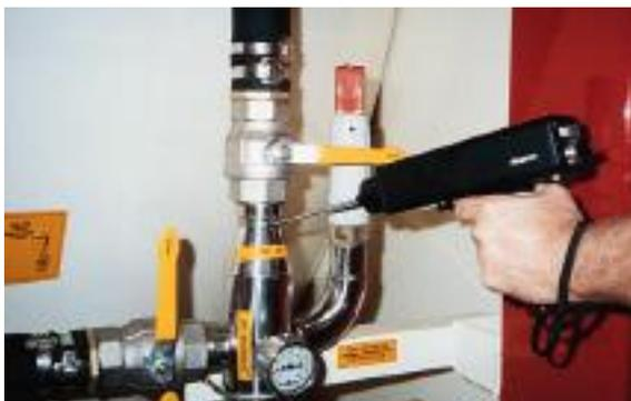
Ilustración 7 Válvula de aire no inspeccionable por termografía
