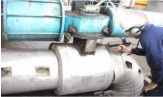
Ilustración 13 Inspección de una válvula con el método ABCD
