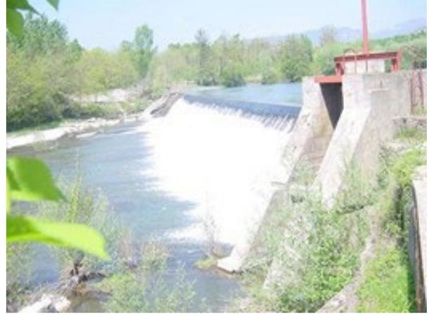
Figura 5 Minicentral hidroeléctrica y azud de captación de canal .(Fuente Enel Power Generation Hydro).
