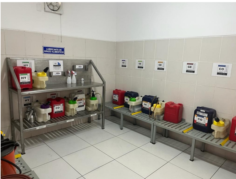
Figura 8. Sala de lubricación con herramientas para manipulación adecuada de lubricantes.
