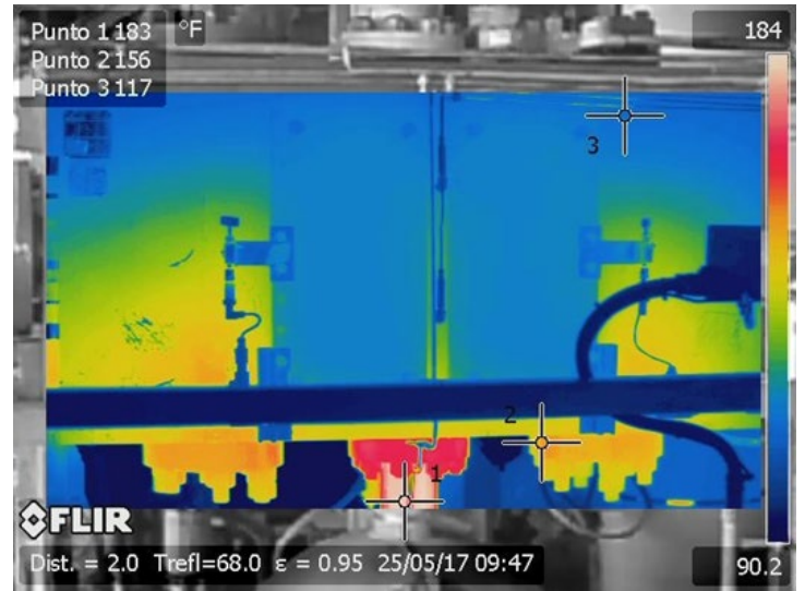
Fig 4. Termograma cilindro compresor Dresser rand, modelo 2HHVL2.
