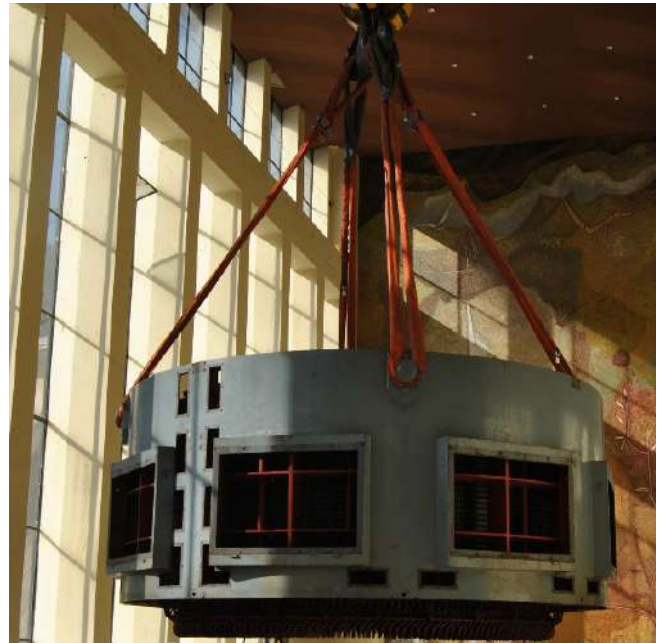
Fotografía 1. Izado estator de grupo hidroeléctrico. Ejemplo de equipo crítico que requiere planificación en las acciones de mantenimiento a ejecutar (Fuente: Enel Green Power-Endesa Generación).
