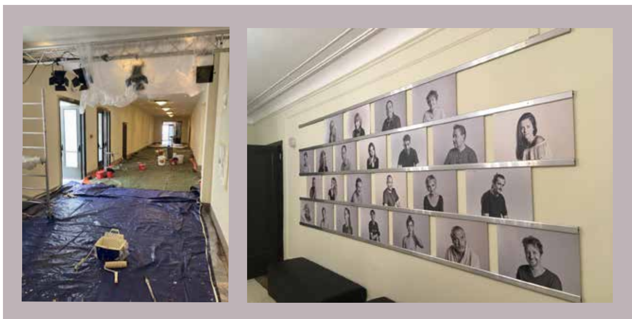
Výmalba a úprava foyer
