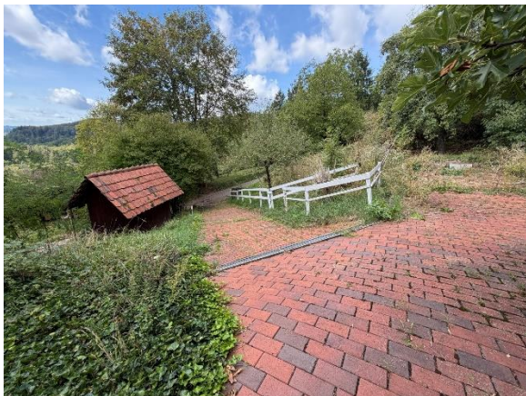
Häusle für die Technik d. Kläranlage
