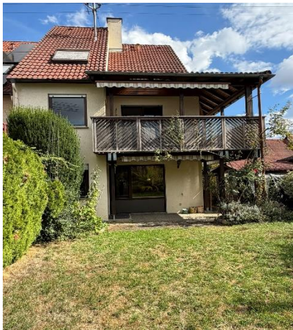
Ansicht Westen, Gartenseite
