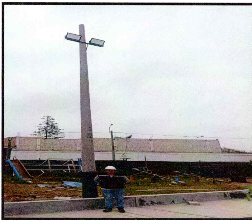
IMAGEN 01: Verificación Postes con Luminaria
