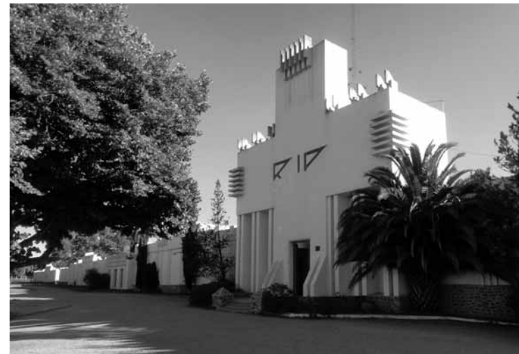
Fig. 2. Fachada del Cementerio de Balcarce, obra del arquitecto Francisco Salamone.
