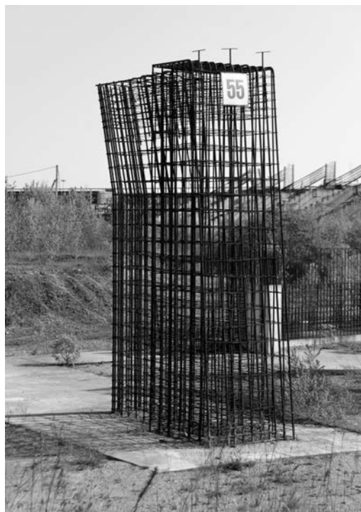
Останки конструкции национального стадиона, Вильнюс, Фото
