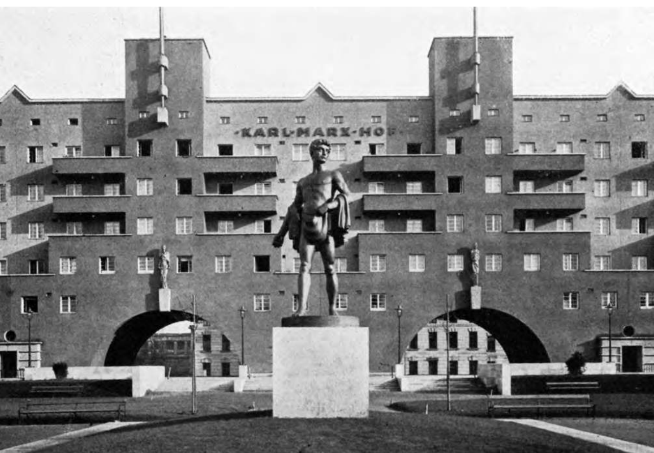
Материал иллюстрирован фотографиями Карл-Маркс-Хофа, памятника социального строительства в Вене (был построен в 1927–1930 годах архитектором Карлом Эном). 12–14 февраля 1934 года Карл-Маркс-Хоф был важнейшим опорным пунктом Февральского восстания; дом был взят правительственными войсками на второй день боев с применением артиллерии.
