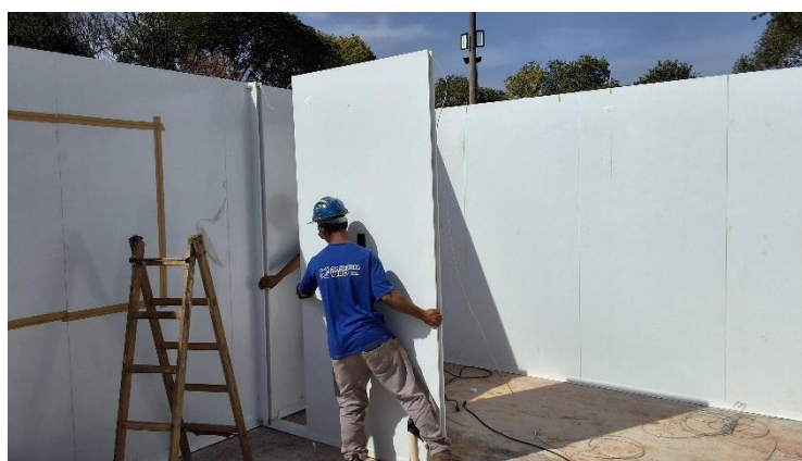
Montagem e instalação dos painéis da Escola José Baldo - 18/08/2025
