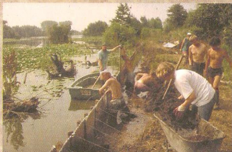
Installation de la tôle
