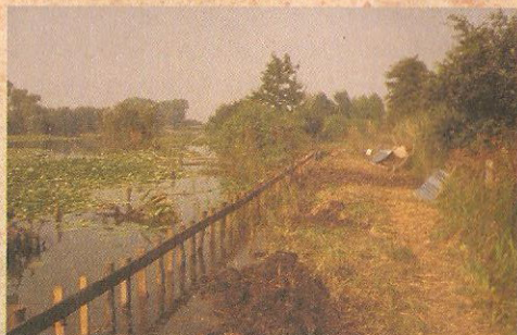
Installation des piquets
