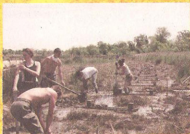
Pose des solives
