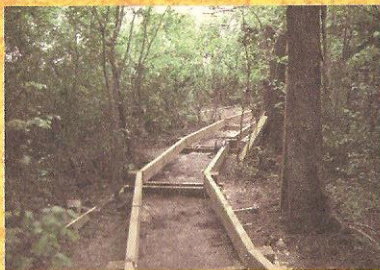
Pose des portiques
