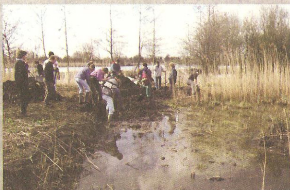
Reprofilage de berges dans le boulonnais
