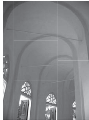
รูปที่ ๓๒ เหล็กเส้นช่วยรับแรงดึงที่ยึด อยู่ระหว่างผนังชั้นในและผนังชั้นนอก
