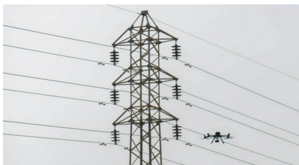
Слика 3: Инспекција далековода/електричних вода дроновима
