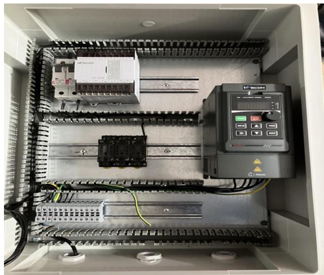
Слика 3.25. Фреквентни регулатор мотора који је инсталиран у постројењу.
