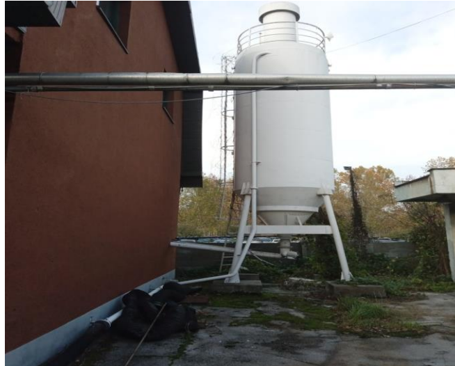
Слика 3.8. Резервоар за смештање базе.
