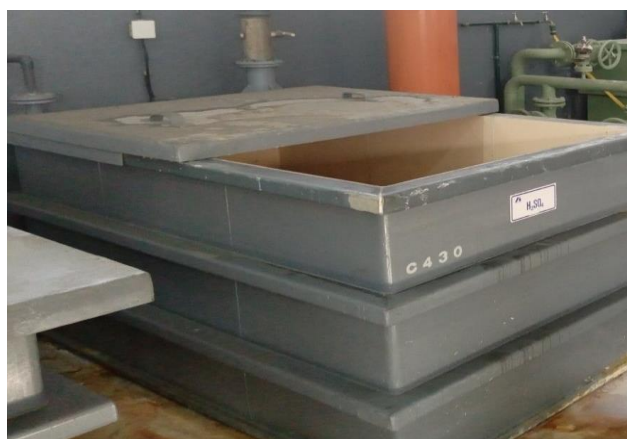
Слика 3.6. Резервоар за припрему киселине.
