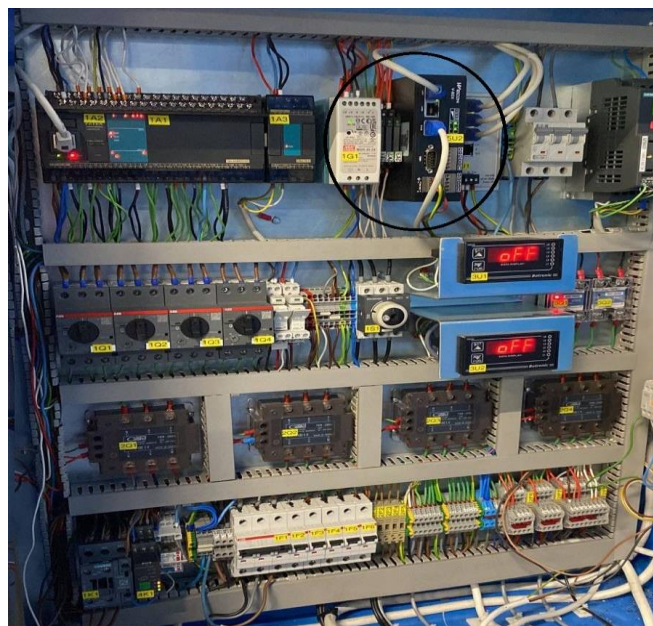
Слика 3.30. V-BOX уређај који је инсталиран у постројењу.
