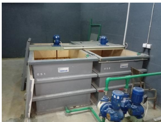
Слика 3.11. Када за припрему полиелектролита.
