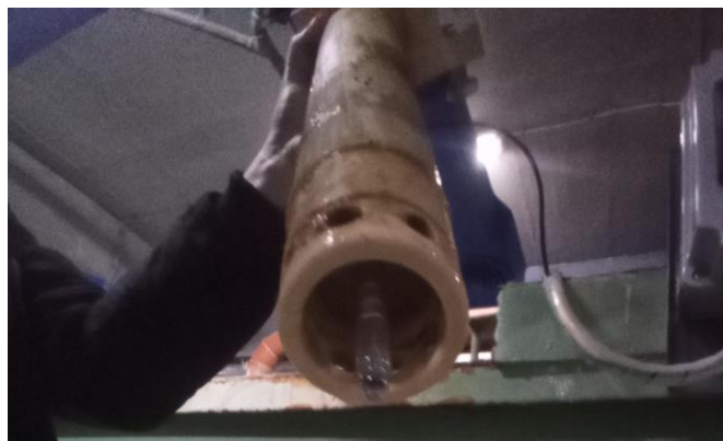
Слика 3.16. Redox електрода која је инсталирана у постројењу.
