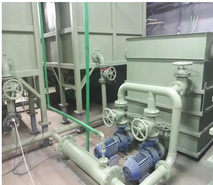
Слика 6.1. Пумпе за избацивање воде.
