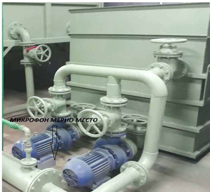
Слика 6.2. Мерно место на којем је постављен микрофон.
