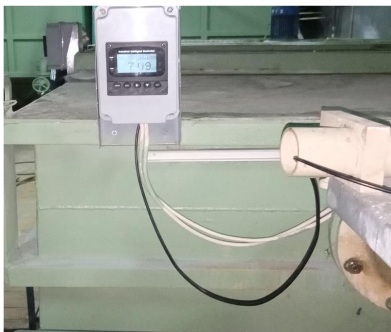
Слика 3.17. Дигитални рН-метар који је инсталиран у постројењу.
