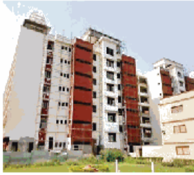
निर्माणाधीन न्यू गल्स हास्टल
