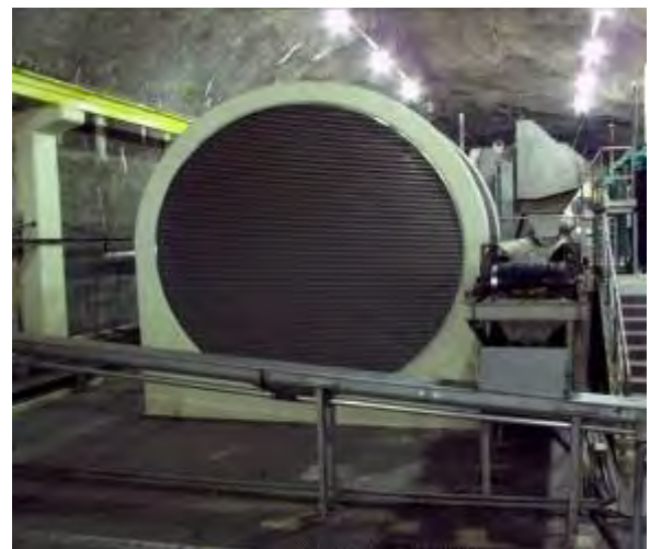
Fig. 8 Exhaust Air Louver
