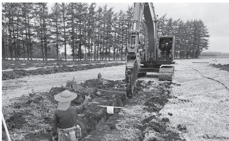
土地基盤整備
