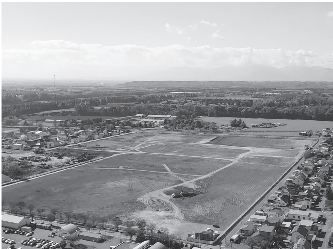
造成中の（仮称）音更町テイセン工業団地
