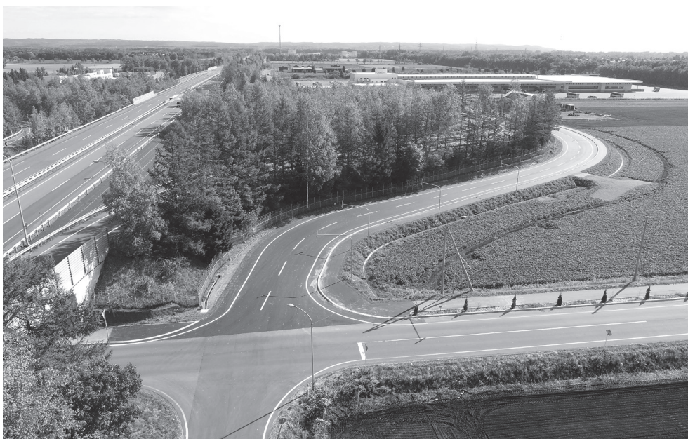
音更然別1号道路整備（車道拡幅及び歩道新設）
