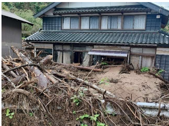
土砂に埋もれた家屋（北河内）
