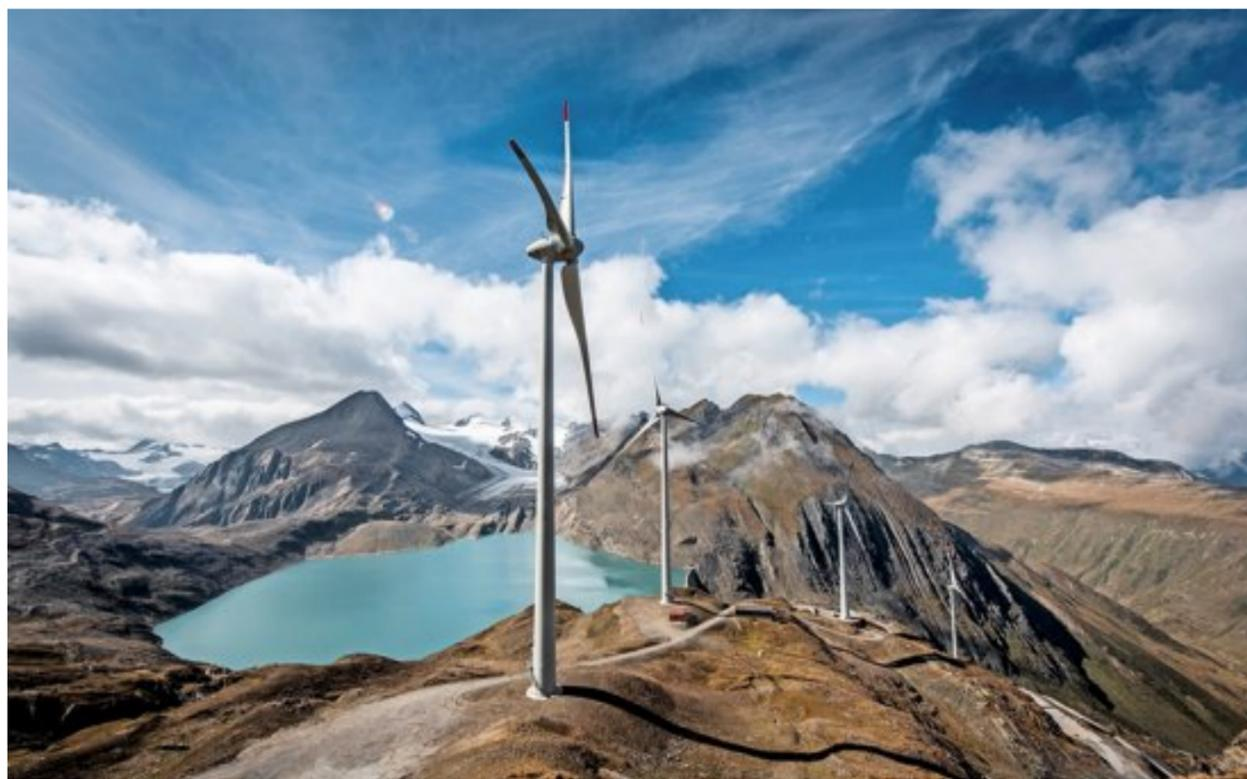
**Auf dem Nufenenpass** ist gestern der höchste Windpark Europas eingeweiht worden. Der Park liegt auf 2465 Metern über Meer, umfasst vier Windräder und produziert zehn Gigawattstunden Strom pro Jahr. Dies entspricht in etwa dem Verbrauch von 2850 Haushalten. *Keystone*
