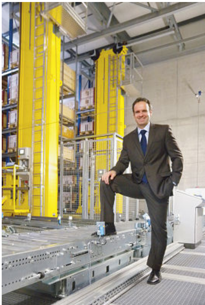
Das Hochregallager ist vollautomatisch, mehrstöckig und von imposantem Ausmass.
