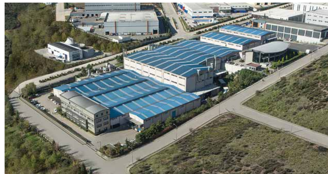
EGGER Gebze kenarbandı üretim tesisi
