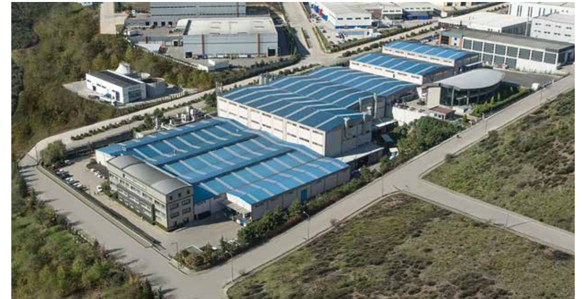
EGGER Gebze kenarbandı üretim tesisi
