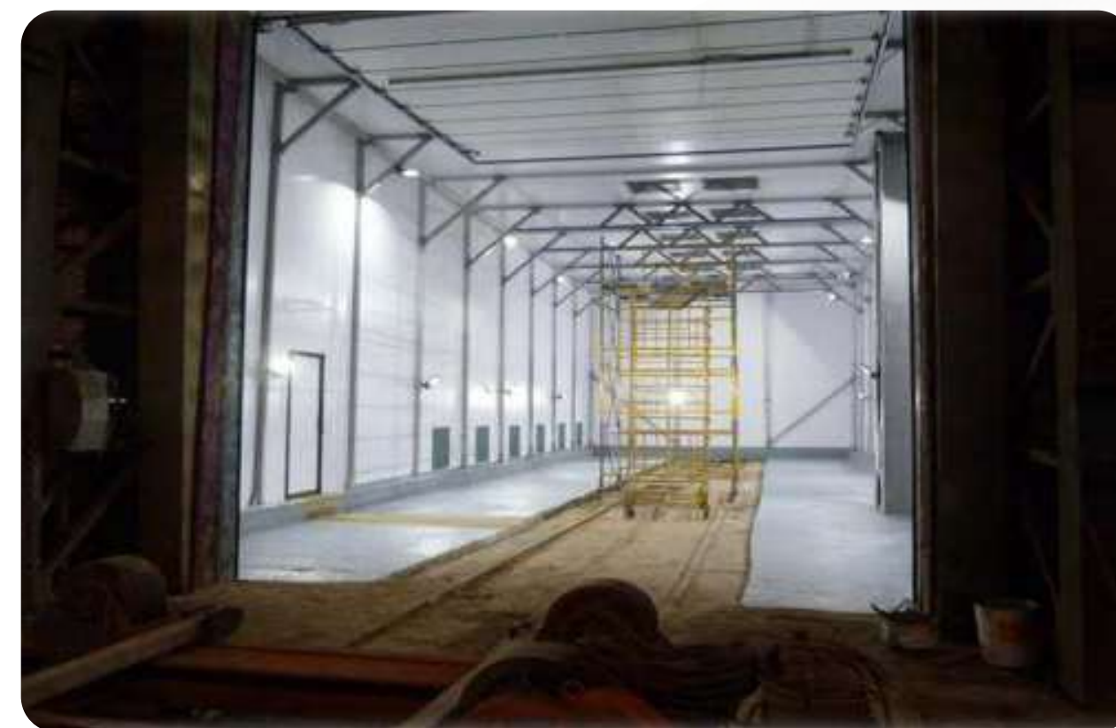
Окрасочно-сушильная камера 21м x 7м x 6м
