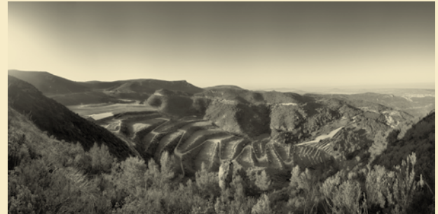
Jordi L. Puig - BRANA Restauración paisajística del vertedero controlado de la Vall d'en Joan, Parque Natural de El Garraf. Barcelona, España. Obra de los arquitectos Enric Batlle y Joan Roig.
