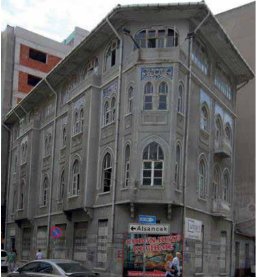
Tekel Eski Başmüdürlük Binasının Görünümü.
