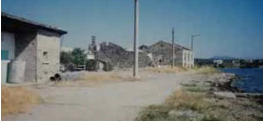
Aliğa Yenişakran Gümrük Binası (İzmir 2 No.lu KVKBK Arşivi) / Aliğa Yenişakran Customs Building (Izmir RCC-2 Archive)
