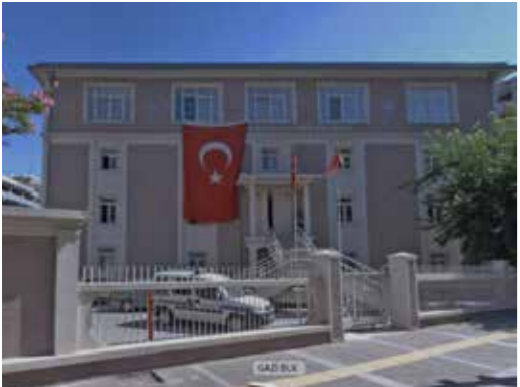
Tekel Tütün Bakım Deposunun Genel Görünümü
