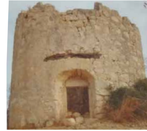
Değirmen Yapısı 3 / Windmill Structure-1
