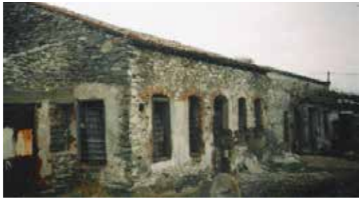
2006 Yılında Eski Tabakhaneinin Genel Görünümü General View of the Old Tannery in 2006 (Yıldırım, 2007)
