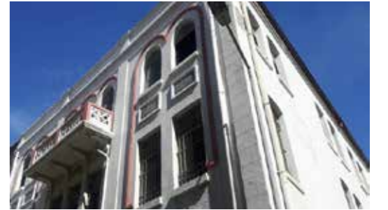
67 Parselde Yer Alan Güneydeki Tescilli Yapı
