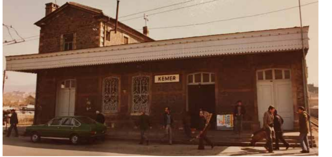
Kemer Yerleşkesi İstasyon Yapısı (İzmir 1 No.lu KVKBK Arşivi) / Station Building in Kemer Compound (Izmir RCC-1 Archive)
