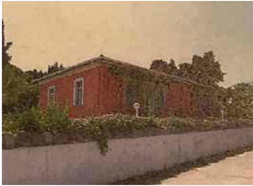
Depo Yapıları (Üstte) ve Konaklama Ünitesi (Altta) (İzmir 1 No.lu KVKBK Arşivi) / Warehouse Facilities (Top) and Accommodation Unit (Below) (Izmir RCC-1 Archive)
