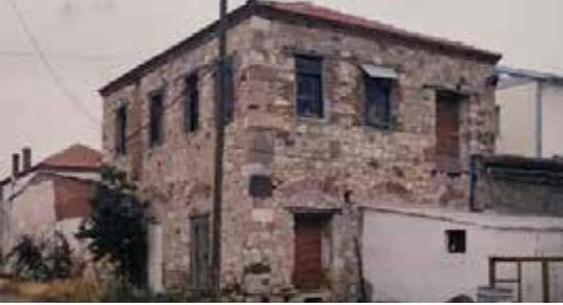
Aliağa Yenişakran Fabrika Yapısı (İzmir 2 No.lu KVKBK Arşivi) /Aliağa Yenişakran Factory Structure (Izmir RCC–2 Archive)
