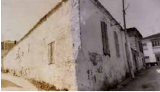
Urla Zeytinyağı Fabrikası II Genel Görünümü, (İzmir 1 No.lu KVKBK Arşivi) / General View of the Urla Olive Oil Mill (Izmir RCC-I Archive)
