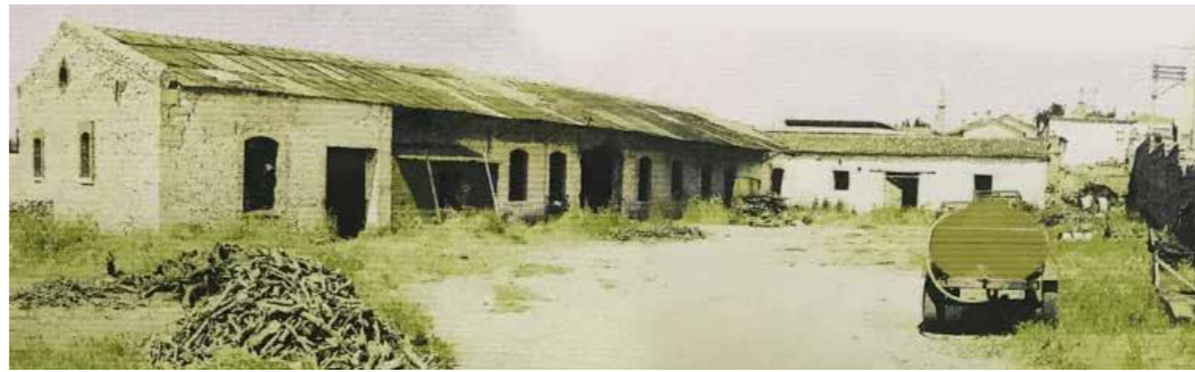
Bergama Zeytindağ Zeytinyağı Fabrikası (İzmir 2 No.lu KVKBK Arşivi) / Bergama Olive Oil Mill (Izmir RCC-2 Archive)
