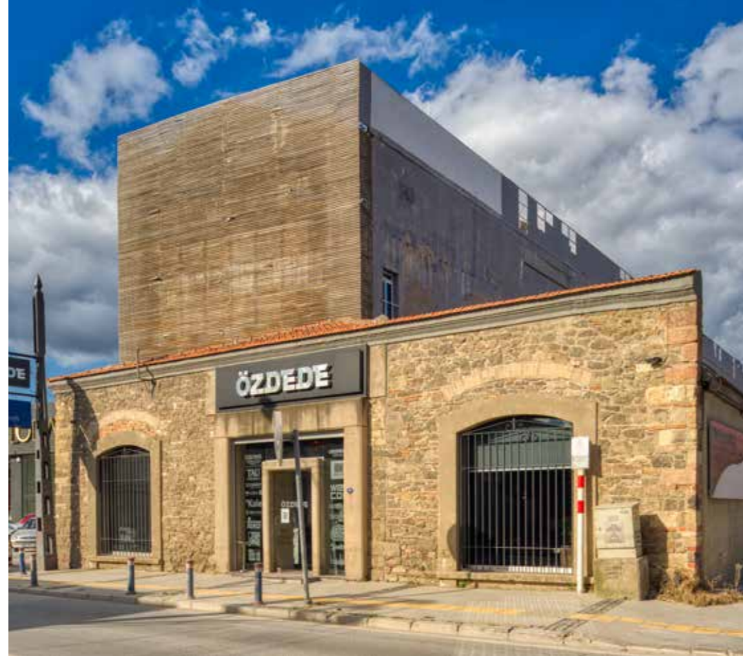
Eski Kiremit Fabrikası (Günümüz) / Old Tile Factory Today
