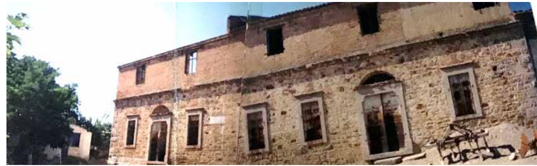
Bergama Zeytinyağı Fabrikası ve Deposu Güney Cephesi (Giriş Cephesi), (İzmir 2 No.lu KVKBK Arşivi) / Bergama Olive Oil Mill and Depot South Façade (Entrance Façade), (Izmir RCC-2 Archive)
