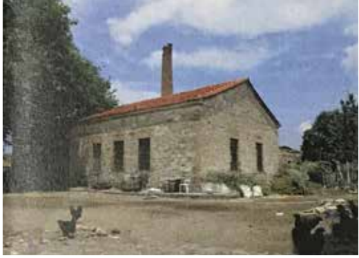
Dikili Bademli Zeytinyağı Fabrikası I'n Genel Görünümü (İzmir 2 No.lu KVKBK Arşivi, 2017) / General View of the Dikili Bademli Olive Oil Mill-1 (Izmir RCC-2 Archive, 2017)
