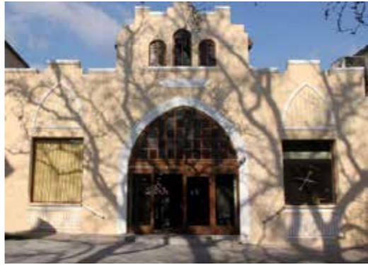
Eski Et ve Sebze Hali'nin (Kapalı Çarşı) Günümüz Görünümü (ETM Mimarlık, 2020) / Old Meat and Vegetable Market (Covered Bazaar) Current View (ETM Architecture, 2020)
