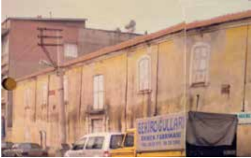
Deponun Genel Görünümü (İzmir 1 No.lu KVKBK Arşivi) / General View of the Warehouse (Izmir RCC–1 Archive)
