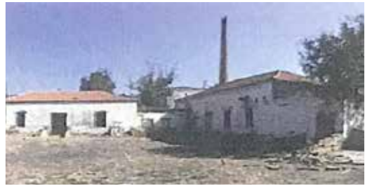
Dikili Bademli Zeytinyağı Fabrikası II Genel Görünümü (İzmir 2 No.lu KVKBK Arşivi) / General View of the Dikili Bademli Olive Oil Mill-2 (Izmir RCC-2 Archive)
