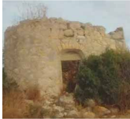
Değirmen Yapısı 2 / Windmill Structure-2
