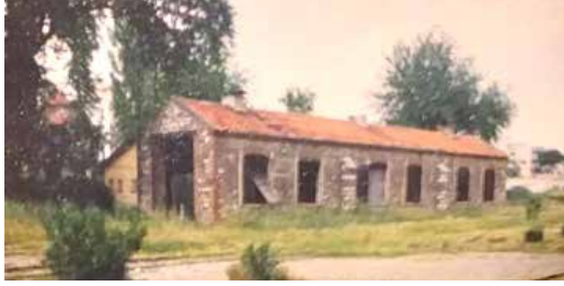
Tire Yerleşkesi'ndeki Yapılar (İzmir 2 No.lu KVKBK Arşivi) / Structures in the Tire Compound (Izmir RCC-2 Archive)
