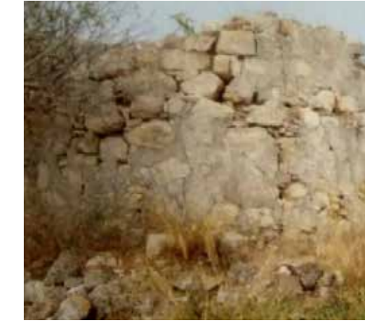
Değirmen Yapısı 4 / Windmill Structure-4
