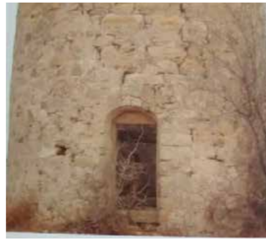
Değirmen Yapısı 6 / Windmill Structure-6
