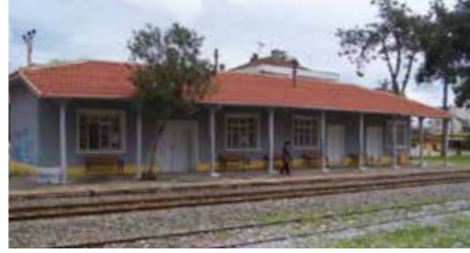
Yerleşkenin Görünümü (Raylardan) / View of the Compound (From the Rails), (Ekizoğlu, 2012)
