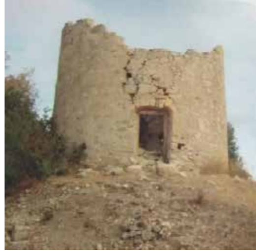
Değirmen Yapısı 1 / Windmill Structure-1
