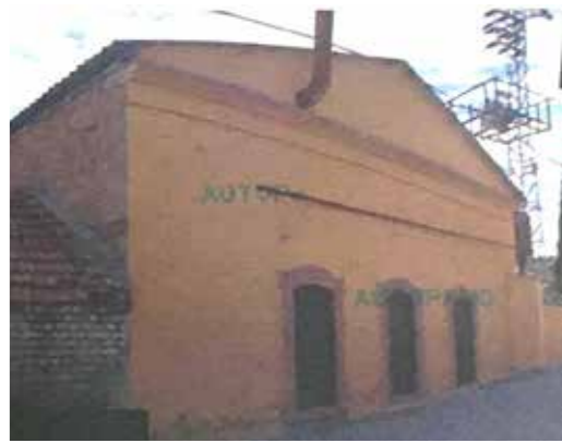
Bergama Sağancı Zeytinyağı Fabrikası II Kuzey Cephesi (İzmir 2 No.lu KVKBK Arşivi) / Bergama Sağancı Olive Oil Mill-2 North Façade (İzmir RCC-2 Archive)
