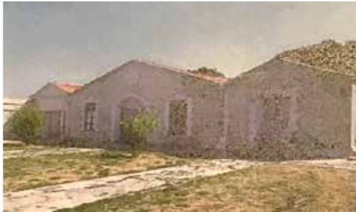
Büyük Tahaffuzhane Binası (Üstte) ve Küçük Tahaffuzhane Binası (Altta) (İzmir 1 No.lu KVKBK Arşivi)
