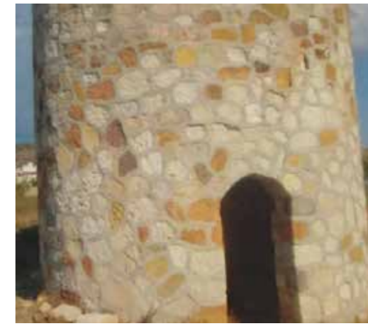
Değirmen Yapısı 7 / Windmill Structure-7
