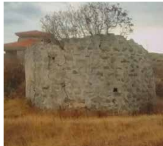
Değirmen Yapısı 5 Windmill Structure-5
