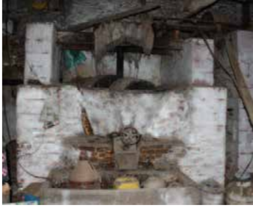
Birgi Zeytinyağı Fabrikası II'nin Taş Değirmeni / Birgi Olive Oil Mill-1 Olive Presses (Yerliyurt ve Manisa, 2014)
