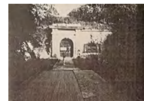
Vue du platelage bois du pont dormant, qui n'était pas encore recouvert de béton
