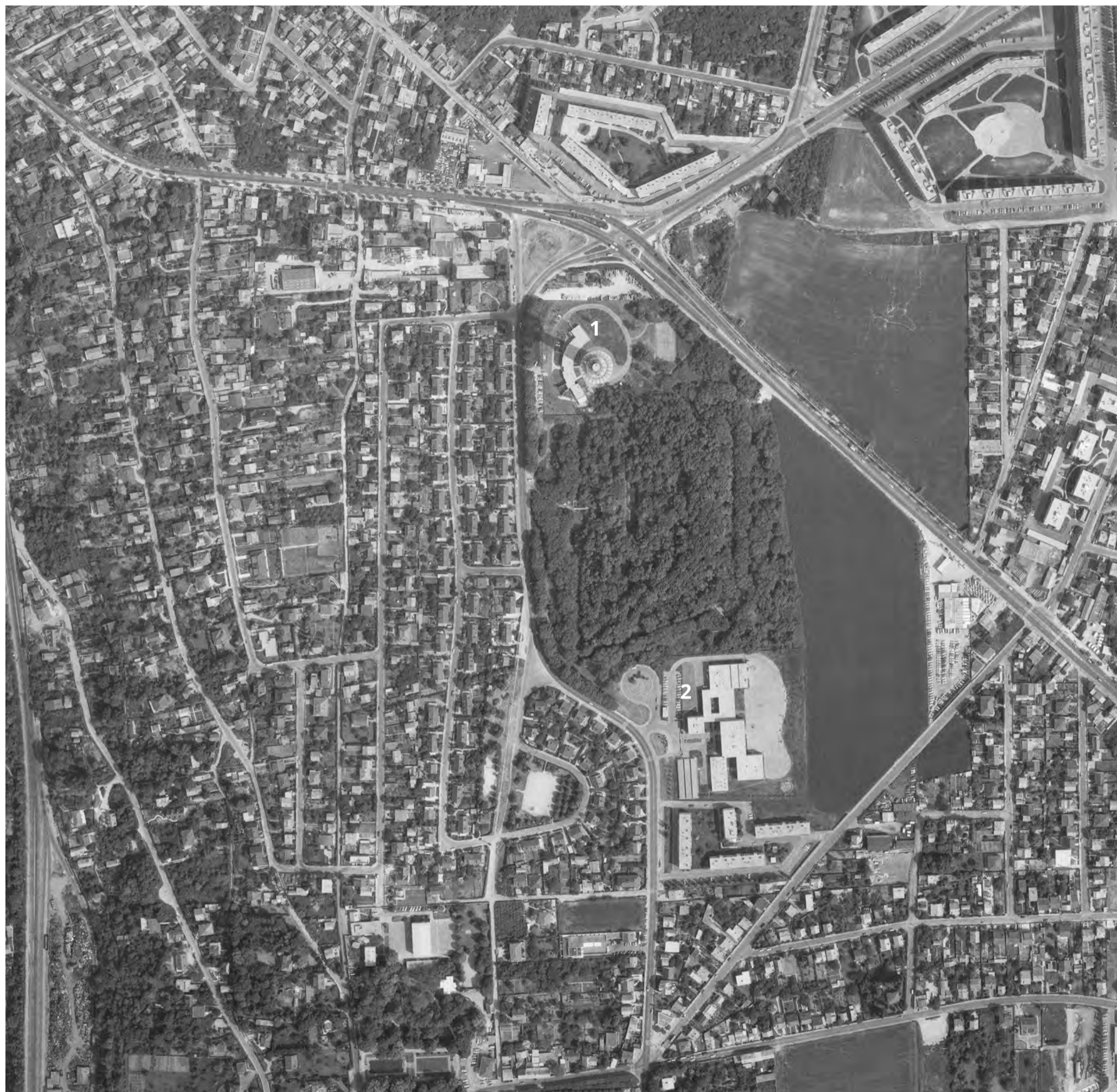
1- Construction de la tour Hertzienne - démolition du fossé nord-ouest 2- Construction du collège
