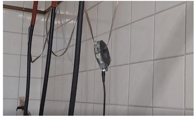
Figura 12 – Instalação do HFCT na malha de aterramento do cabo medido.
