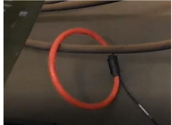
Figura 13 – Instalação do sensor de Rogowski no cabo medido.
