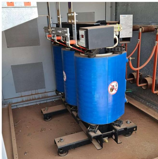
Fig. 1. Transformador trifásico 500 kVA instalado na subestação interna ao hospital.
