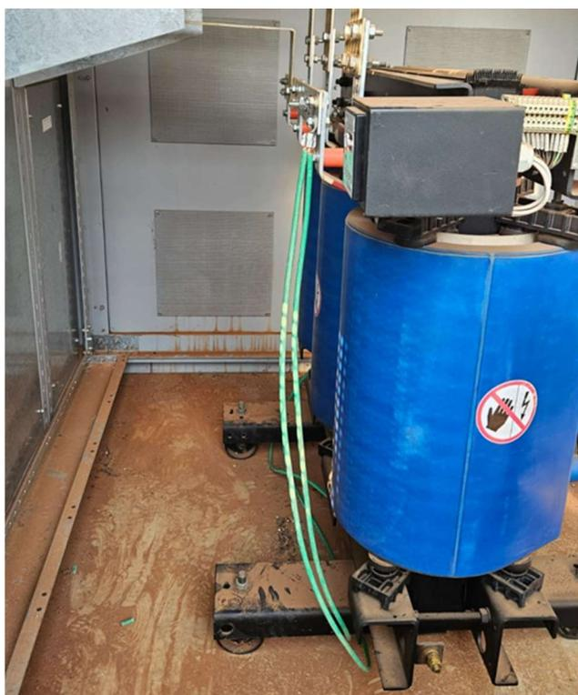
Fig. 5. Transformador trifásico 500 kVA instalado na subestação interna ao hospital após o ajuste de conexões no aterramento.
