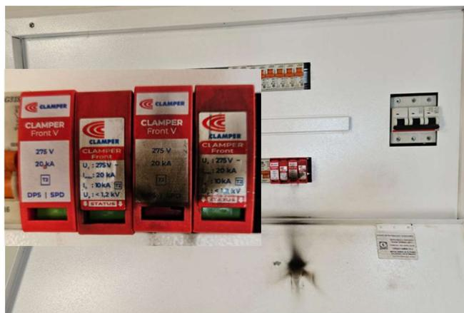
Fig. 3. Dispositivos de Proteção contra Surtos (DPS) Classe II queimados.
