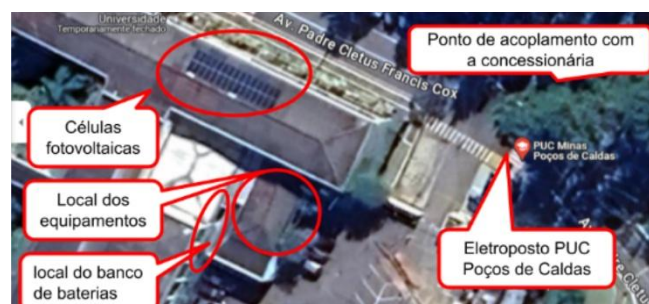
FIG 2: DISTRIBUIÇÃO DOS EQUIPAMENTOS Fonte: Próprio autor
