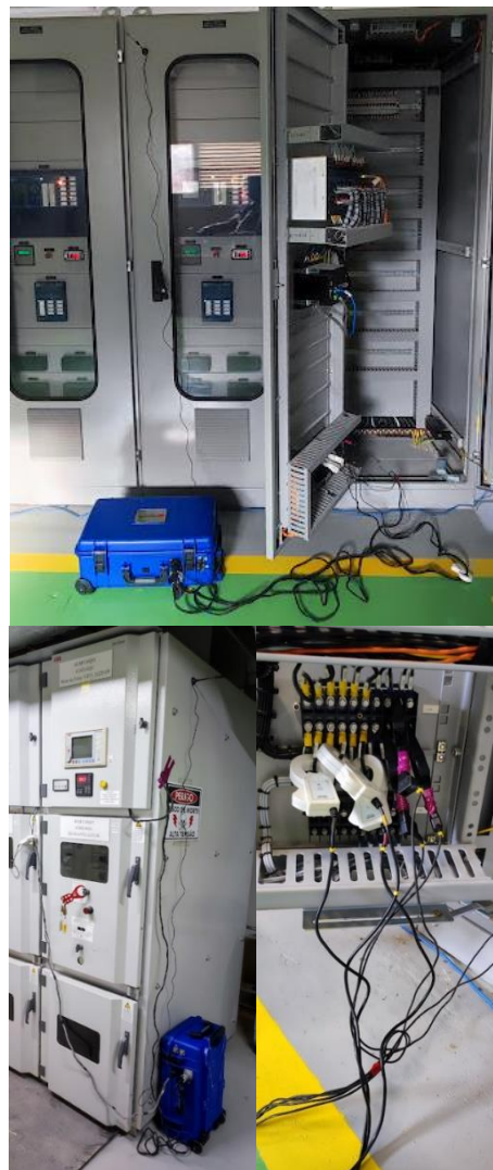
Figura 4 – Esquema de Conexão do Analisador de Energia
