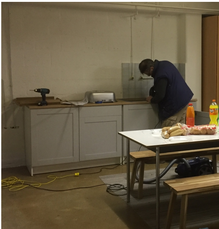
De kraan in het aanwezige keukenblokje wordt aangepast zodat er alleen koud water aanwezig is.
