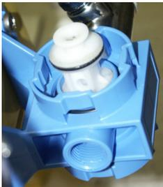
4. O-Ring mit Hahnfett einfetten, Kolben mit nebeneinanderliegenden Bohrungen zur Wasserzulaufseite einsetzen
