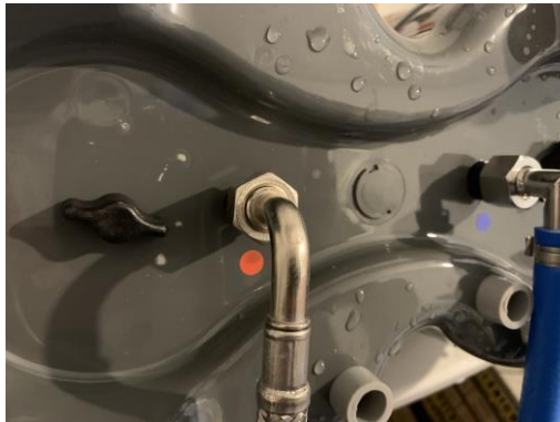
Abbildung 15: Unterseite des untersuchten Gläserspülgerätes mit farblichen Hinweisen zum Anschluss der Kalt- und Warmwasserleitung
