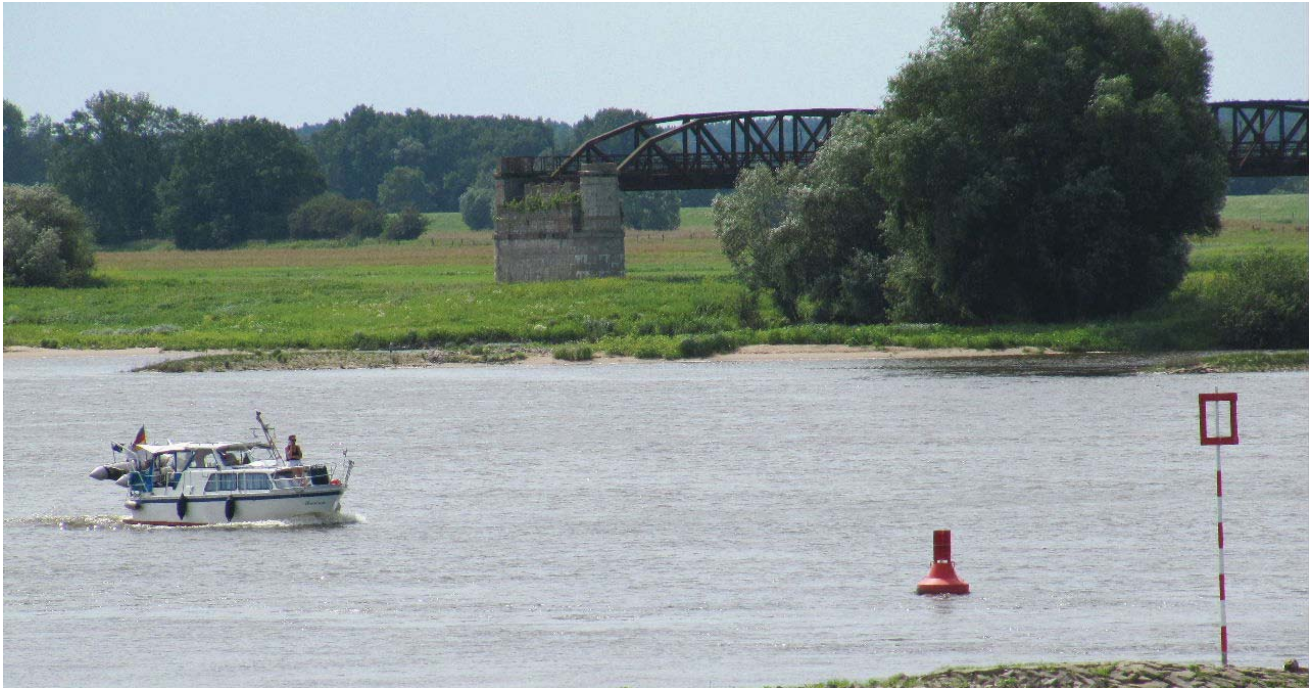
Ruine der Brücke bei Dömitz
