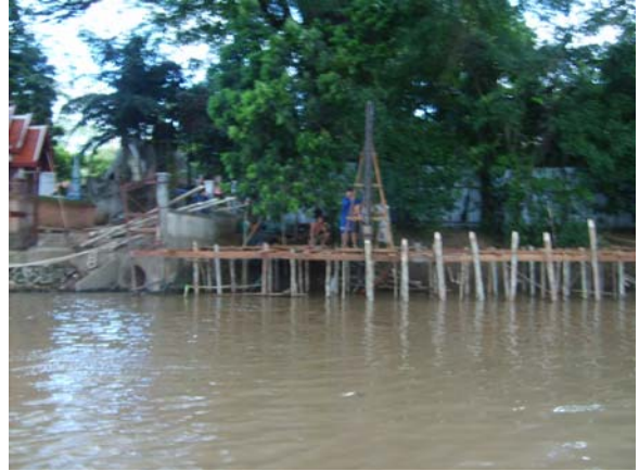
Ved floden, hvor arbejder hamrer pæle i
