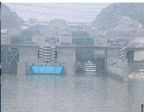
sluserne ved dæmningen
