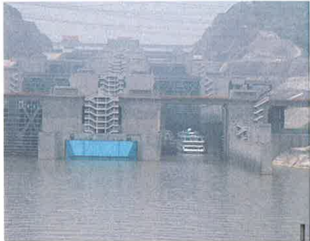
Drei Schluchten Staudamm, Schleusen
