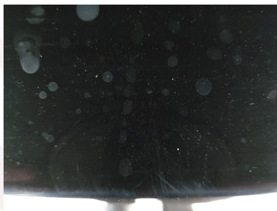
Schaden 4: Stoßfänger hinten - Kratzer
